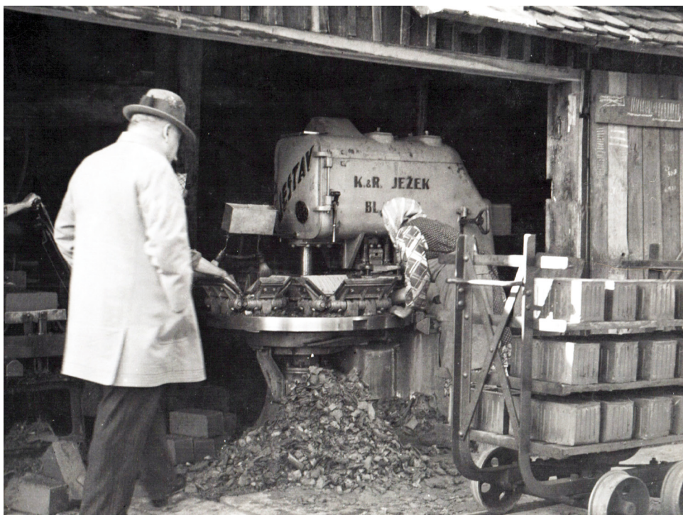
Výroba cihel Jestav v okříšské cihelně (počátek 40. let 20. století). MZA Brno, G 169 Rodinný archiv Collaltů, karton 467, inv. č. 516.
